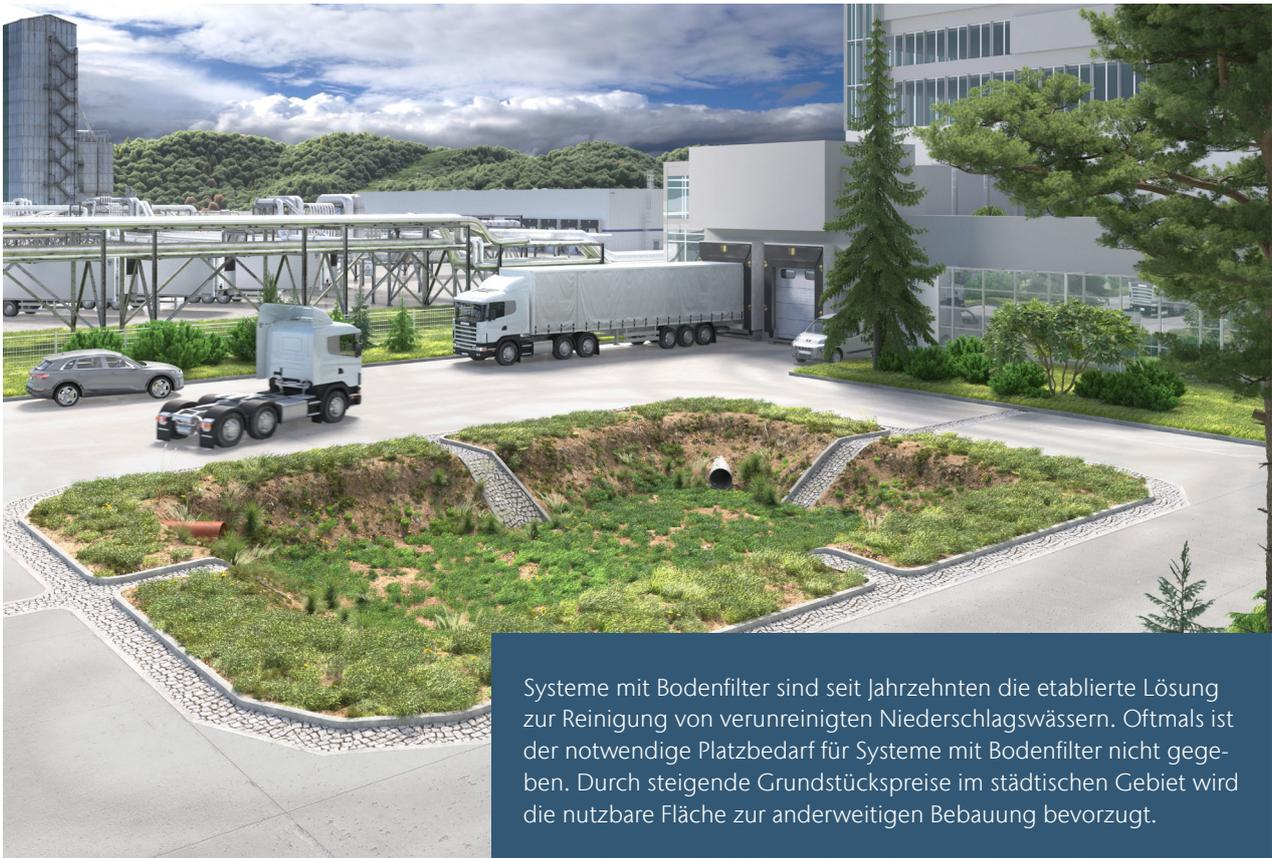
Systeme mit Bodenfilter sind seit Jahrzehnten die etablierte Lösung zur Reinigung von verunreinigten Niederschlagswässern. Oftmals ist der notwendige Platzbedarf für Systeme mit Bodenfilter nicht gegeben. Durch steigende Grundstückspreise im städtischen Gebiet wird die nutzbare Fläche zur anderweitigen Bebauung bevorzugt.
